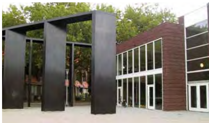
Foto van de buitenkant - 5 oktober 2005
